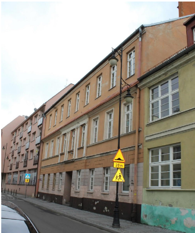
Uszkodzenia elewacji na ścianie szczytowej i na gzymsach.
