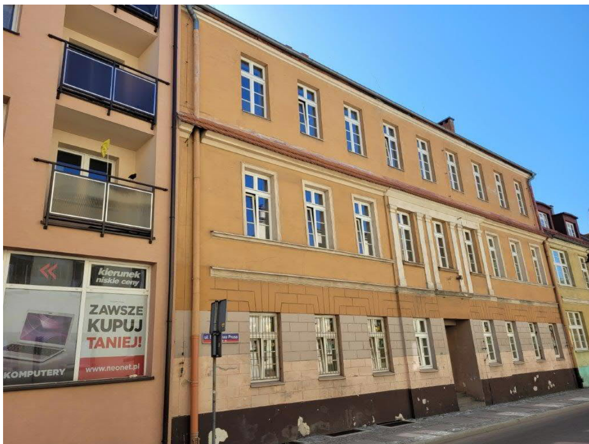
Widoczne uszkodzenia elewacji w części cokołowej.
